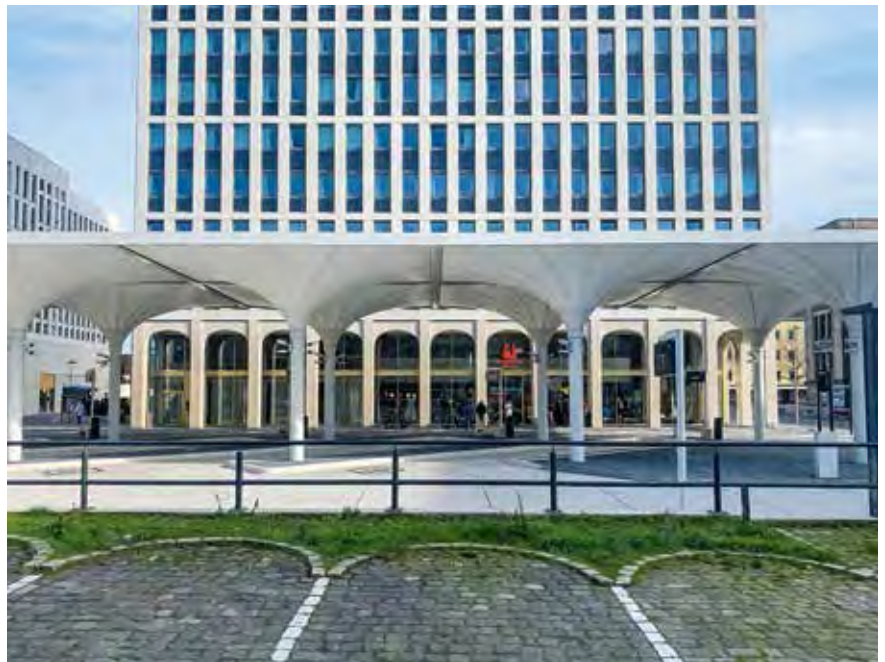
Ansicht des neuen Fernbusterminals. | Foto: Robert Uhde
