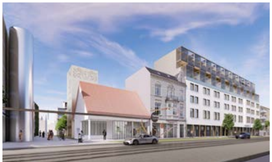
Straßenseitige Ansicht des Quartiers mit Wohngebäude, Gewerbe und Klimaturm zur Wärme- und Kälteerzeugung (Turm rechts mit Schriftzug Hachez)
