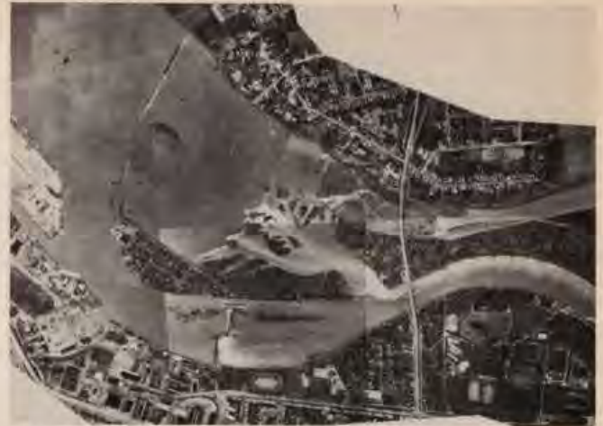
Luftaufnahme Staustufe Bremen mit seitlichem gesetzlichem Hochwasserabflußgebiet am 16. März 1981. Bildung einer Erosionsrinne bei Hochwasser mit 2400 \text{ m}^3/\text{s} (Freigabe durch Regierungspräsident Münster Nr. 515/81)
