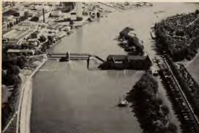
Ansicht des Weserwehres Blickrichtung weseraufwärts, die Hubinsel an der Böschung neben der Kammerschleuse markiert etwa die künftige Wehrachse
