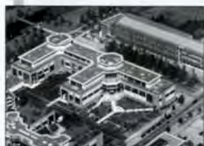
Produktions- und Verwaltungsgebäude Brulter Daltonik (Technologiepark Urii Bremen)
