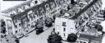
Eigentumswohnungen und neue Stadthäuser im „Buchenquartier“: Zu den vorhandenen Eigentumswohnungen entstehen unsere neuen vielfältigen Stadthäuser mit Größen von 100 bis 160 m 2 .
