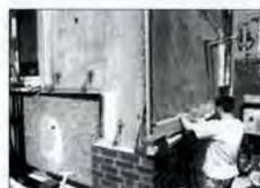
Fassaden-Sanierung in Bremen-Kattenturm
